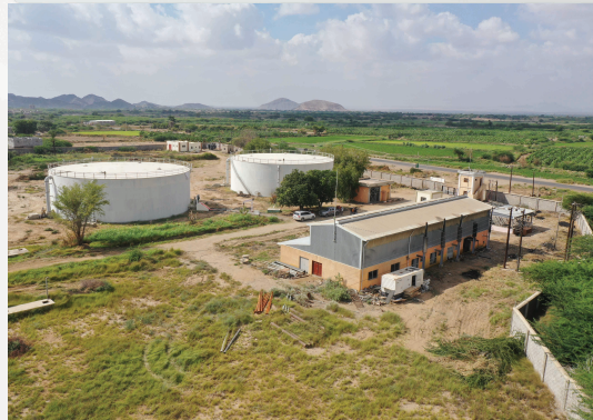
مشروع إعادة تأهيل مياه عدن الكبرى
