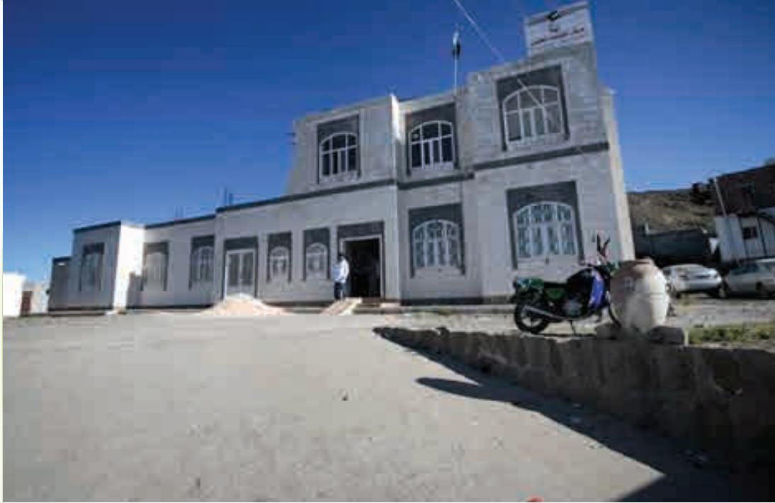
إنشاء وتشغيل مركز الكويت الطبي - صنعاء
