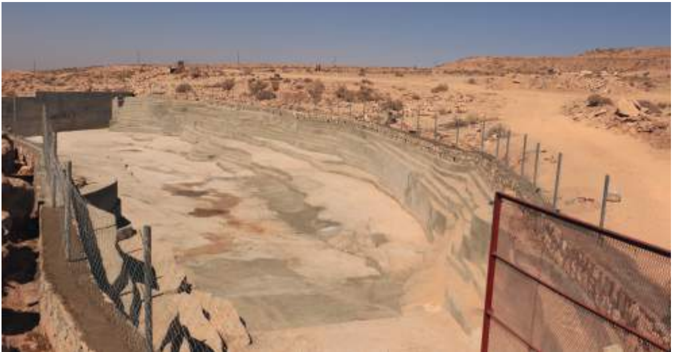
إستكمال إنشاء سد مهينة ( منطقة أرياف المكلا ) - حضرموت Completion of the construction of Mahina Dam (Al-Mukalla rural area) - Hadramaut
