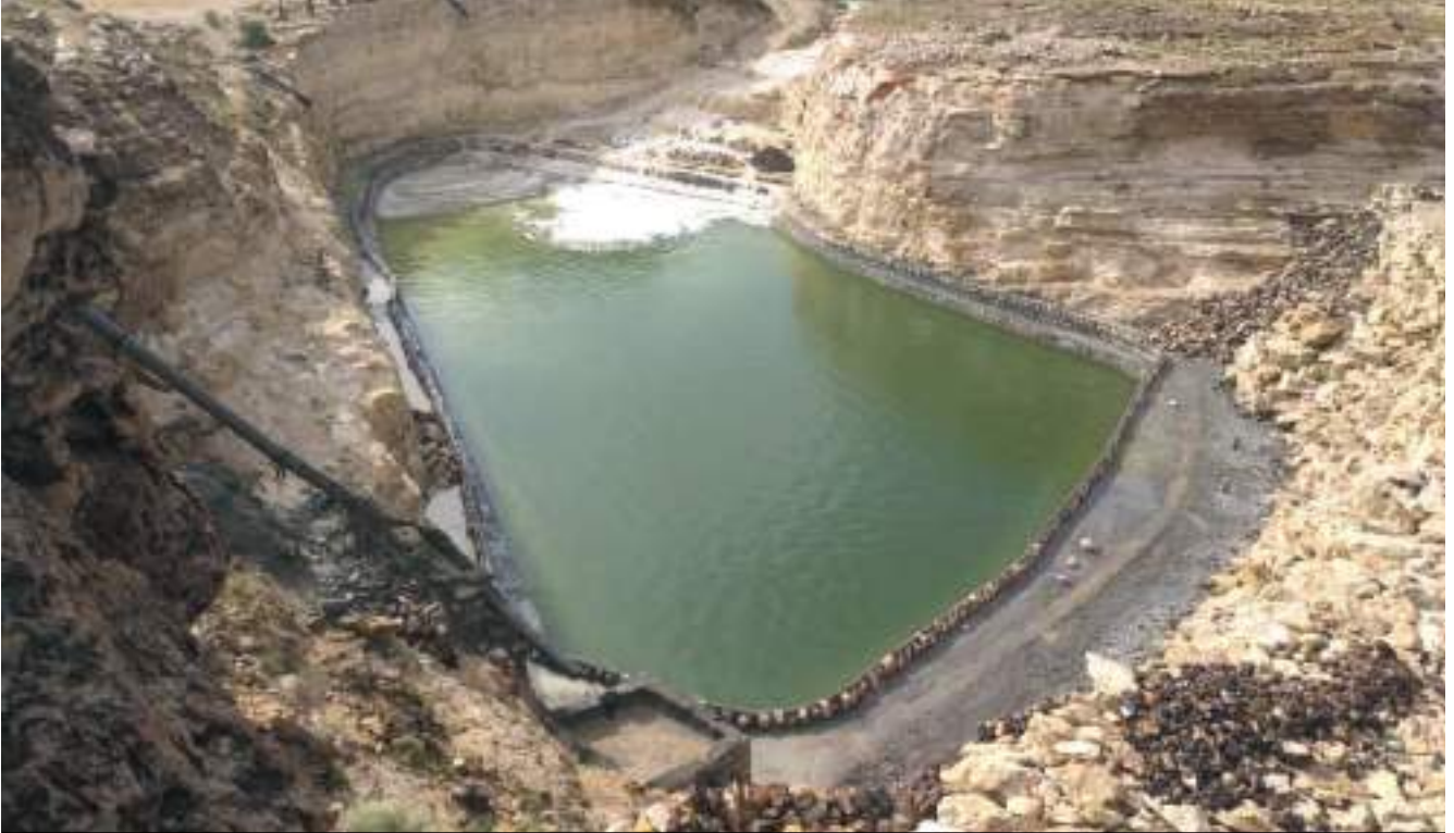
إستكمال إنشاء سد جوزر (حمر يتم ) - المهرة Completion of constructing the Gozer Dam (Hameretam) - Al maharah
