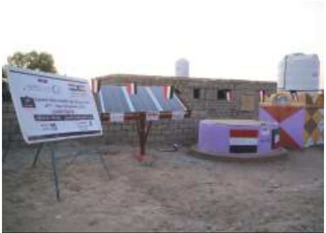
مشروع حفر بئر قرية البهيدر . الحديدة Al-Bahidar village well - Al hodiedah
