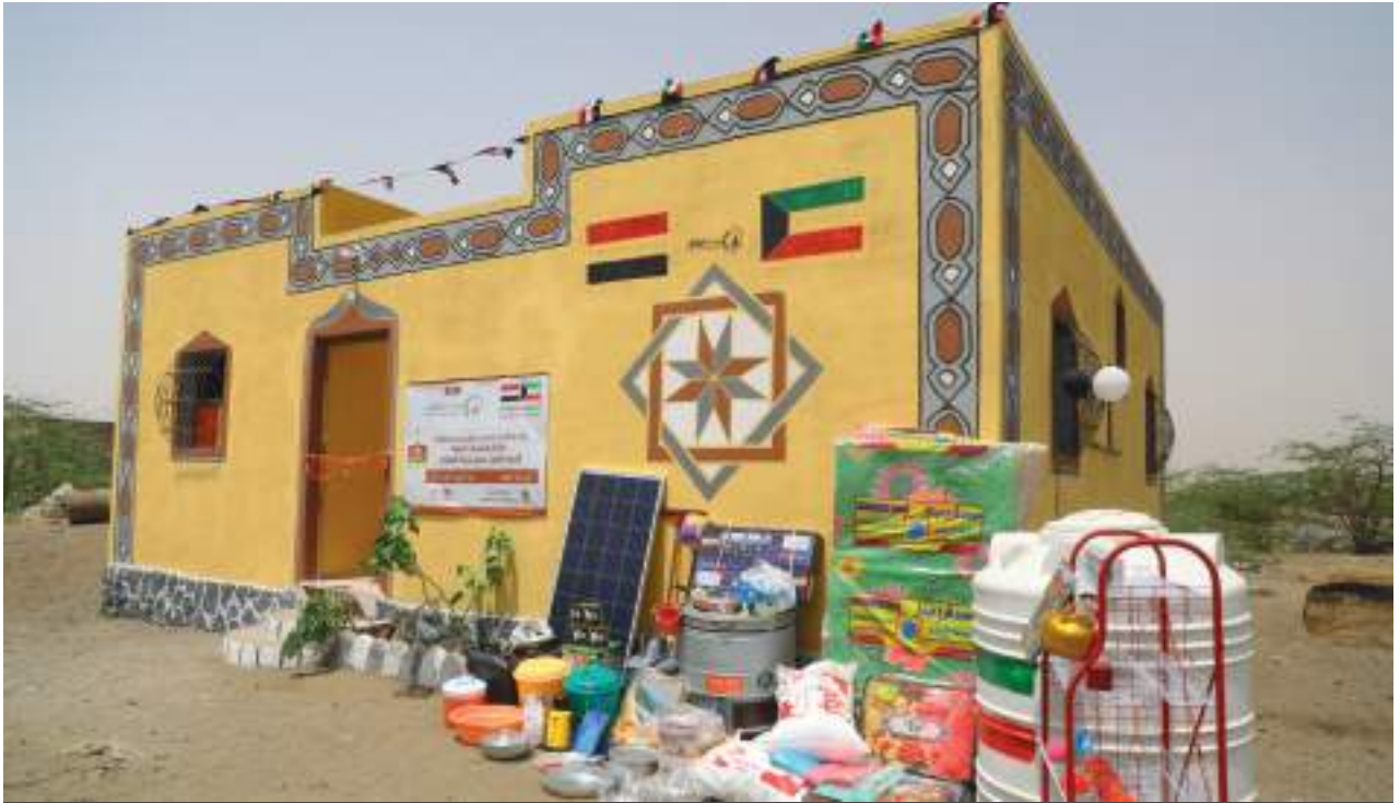
بناء وتأثيث منزل . الحديدة Building and furnishing house - Al Hodiedah
